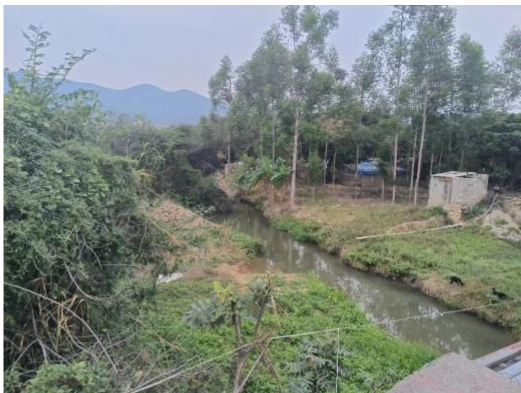
图 3.4-4 排洪渠终点现状
